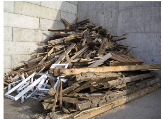
Gefährliche Abfälle wie mit chlororganischen Holzschutzmitteln behandelte Hölzer werden separiert und getrennt entsorgt. (Quelle: Hämmerle GmbH, Konstanz)
