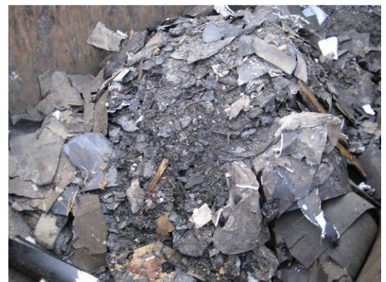
Gefährliche Abfälle wie Asbestprodukte, Dachpappen etc. werden getrennt gelagert und entsorgt. (Quelle: Hämmerle GmbH, Konstanz)
